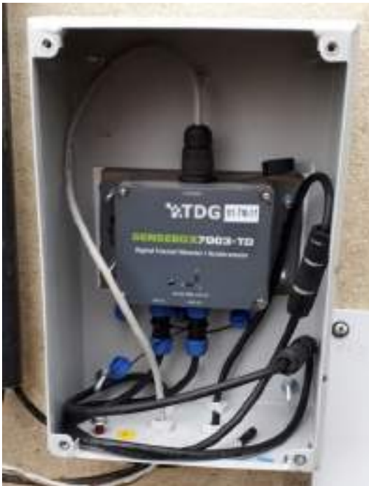
Figuur 39: bevestiging Tiltmeter inclusief bekabeling
