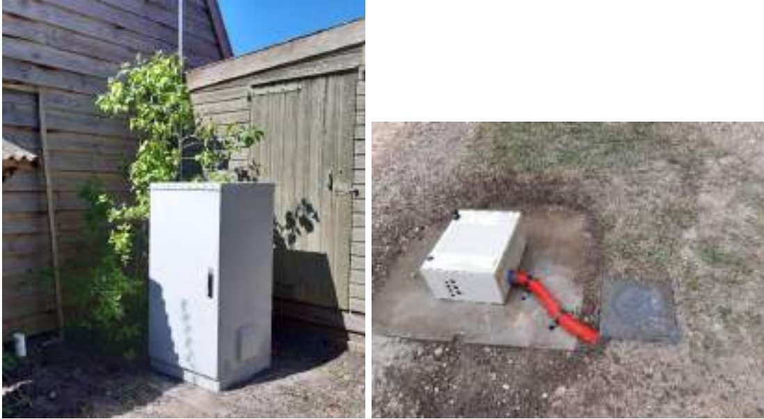
Figuur 31: Foto van een geplaatste betonnen meetplaat met beschermingskast
