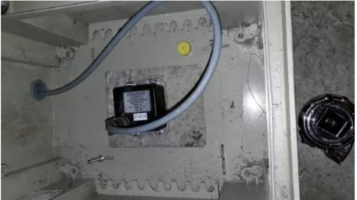
Figuur 33: Plaatsing accelerometer op verharde vloer in het object
